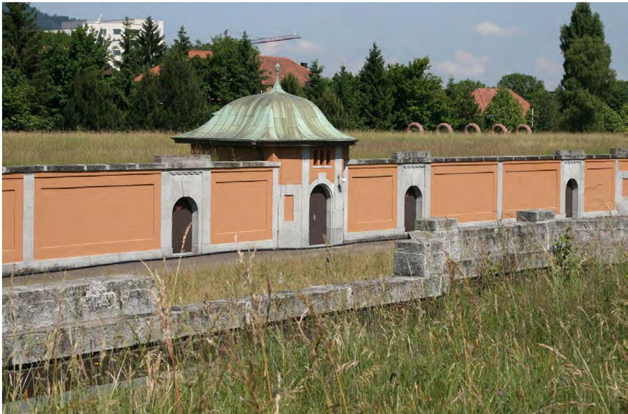
Abbildung 4: Seewasserwerk Moos, Zürich - Erbaut 1914 mit Flachdach, Humuseindeckung aus der unmittelbaren Umgebung
