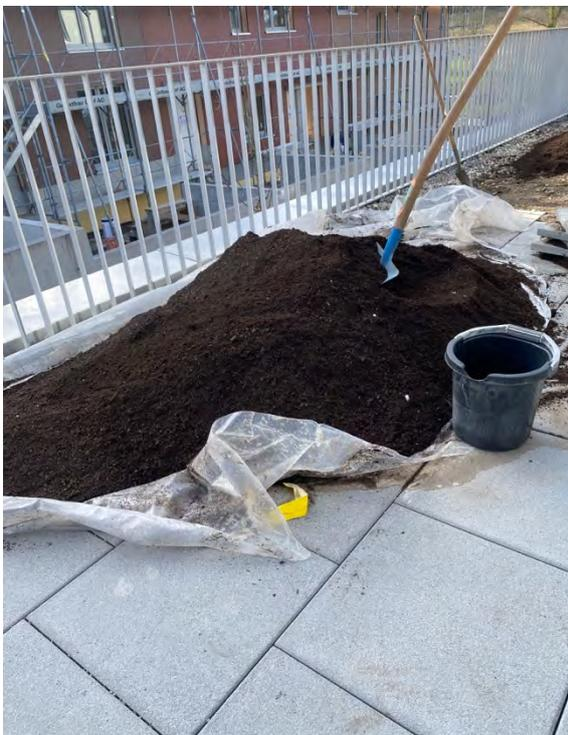
Abbildung 63: Ricoter Dachgartenerde 204 wird eingeblasen. Leider zu viel im OG und zu wenig im DG
