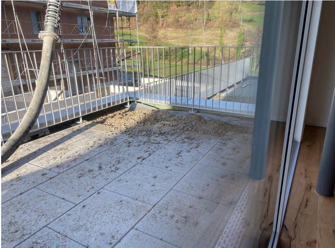
Abbildung 61: Betonkies wird eingeblasen
