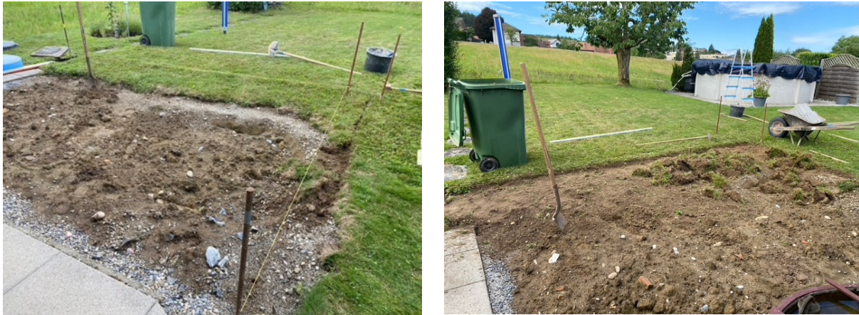
Abbildung 21: Links Absteckung und rechts neue Pflanzfläche
